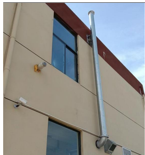
燃气锅炉 8m 高排气筒
