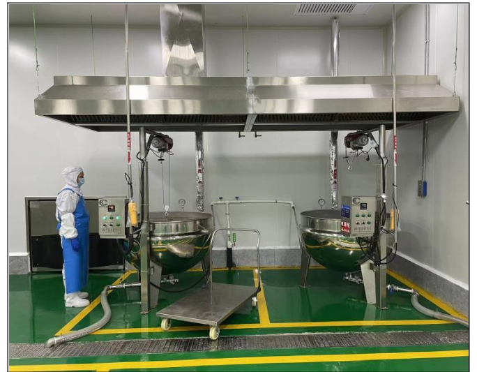
蒸煮锅废气收集设施
