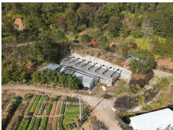
（项目部分边坡区域）
