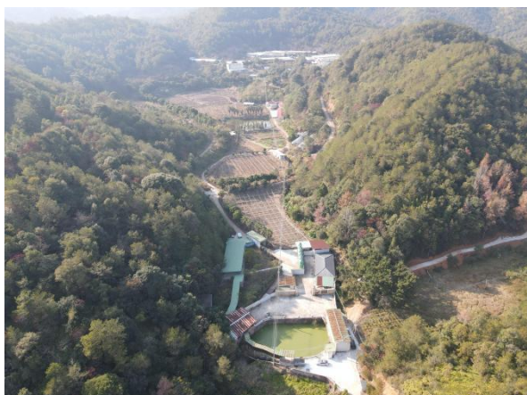
（项目部分全景航拍图）
