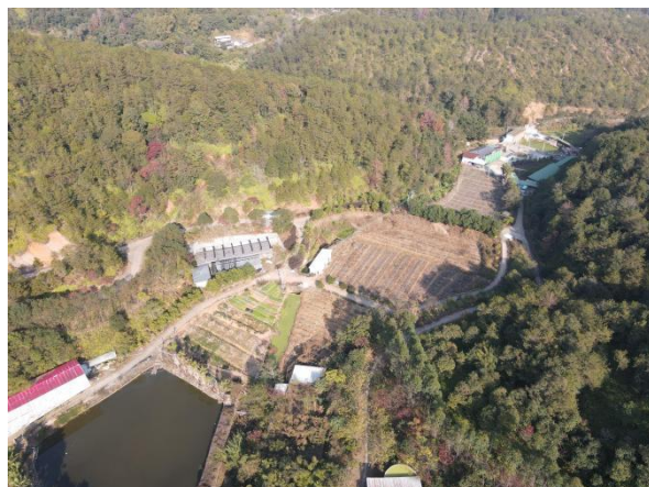
（项目部分边坡区域）
