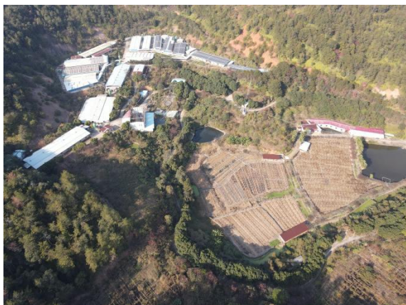
（项目部分全景航拍图）
