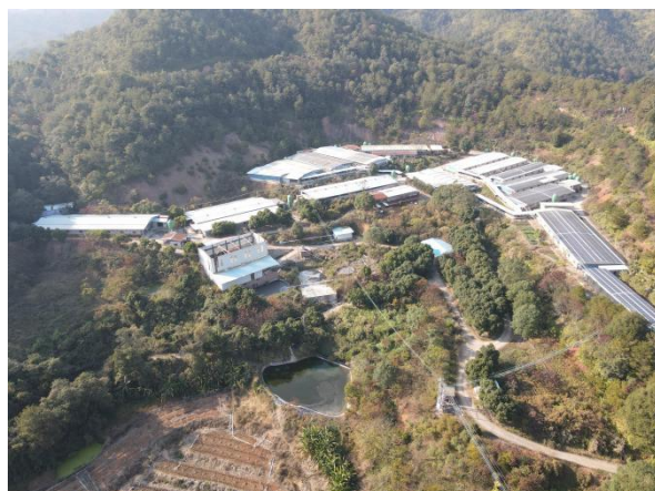
（项目部分全景航拍图）
