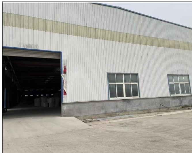
本项目生产车间
