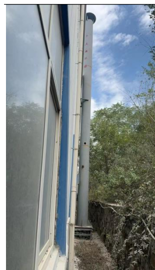
15m 高排气筒
