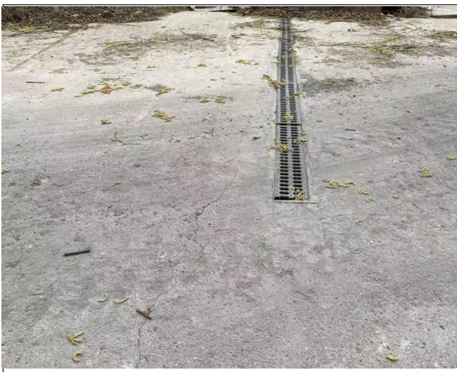
车辆冲洗设施
