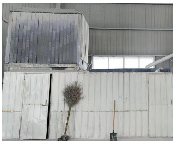
给料、筛分、破碎工序全封闭
