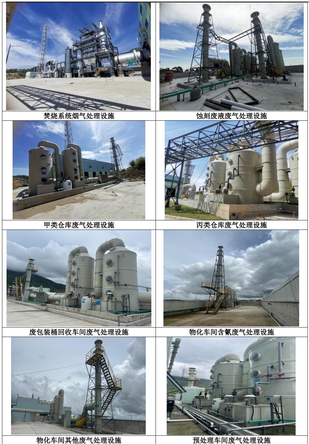
图 4.1-4 部分废气处理设施照片
